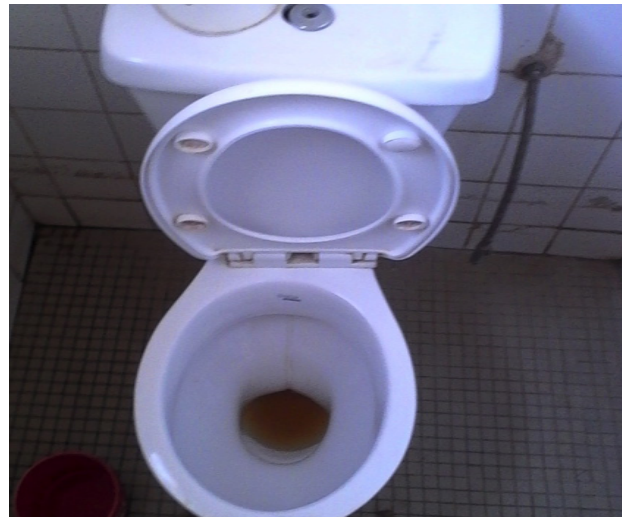
Photo 2 : Toilette quartier «Pépinère» (Pikine/Nord)
