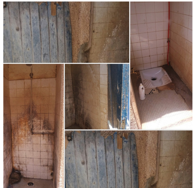
Photo 25 : Toilette Lycée Limamoulaye
