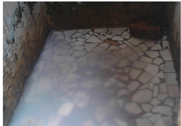
Photo 6 : Toilette bouchée à Thiaroye/Mer
