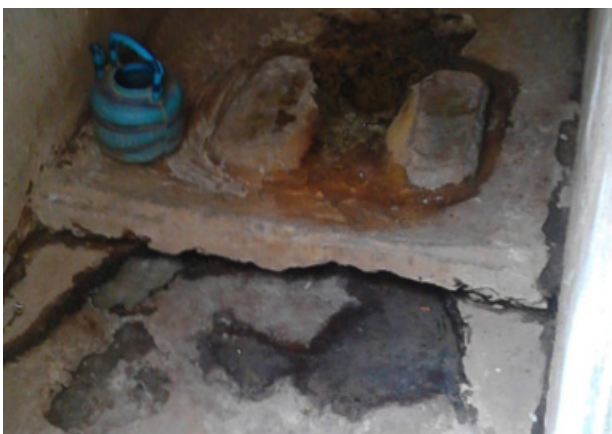
Photo 7 : WC non-aménagée à Thiaroye
